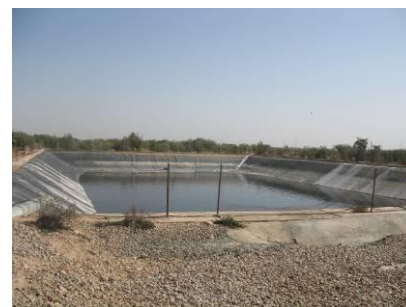
Bassin de récupération des lixiviats
