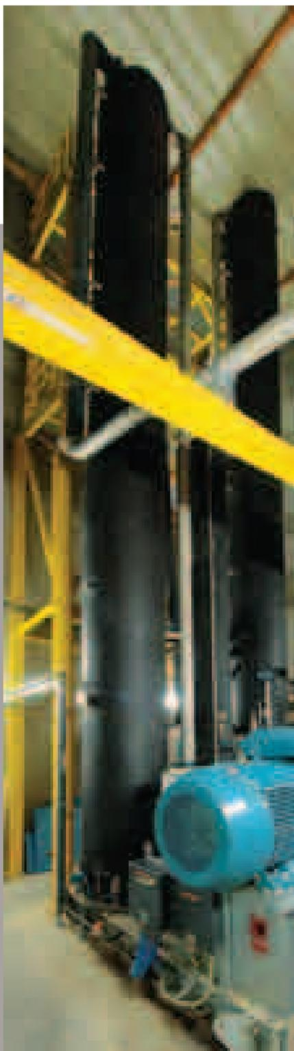
Le reste de l'installation sert en fait à régénérer l'eau de lavage. La pression est successivement abaissée à 4 bars puis à la pression atmosphérique pour désorber le CO<sub>2</sub> et les autres gaz dissous dans l'eau. L'eau ainsi libérée des éléments dissous peut être recyclée et réutilisée pour un nouveau cycle de lavage. À noter que l'eau utilisée provient de la récupération d'eau de pluie sur les toitures du bâtiment.
